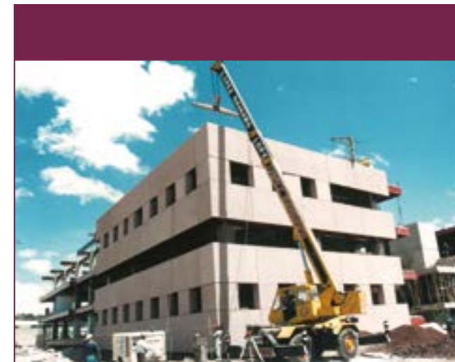
Construcción del CIC, 1995.
